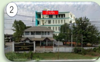
เขตสุขภาพที่ 8 (อ.เมือง จ.อุดรธานี)
