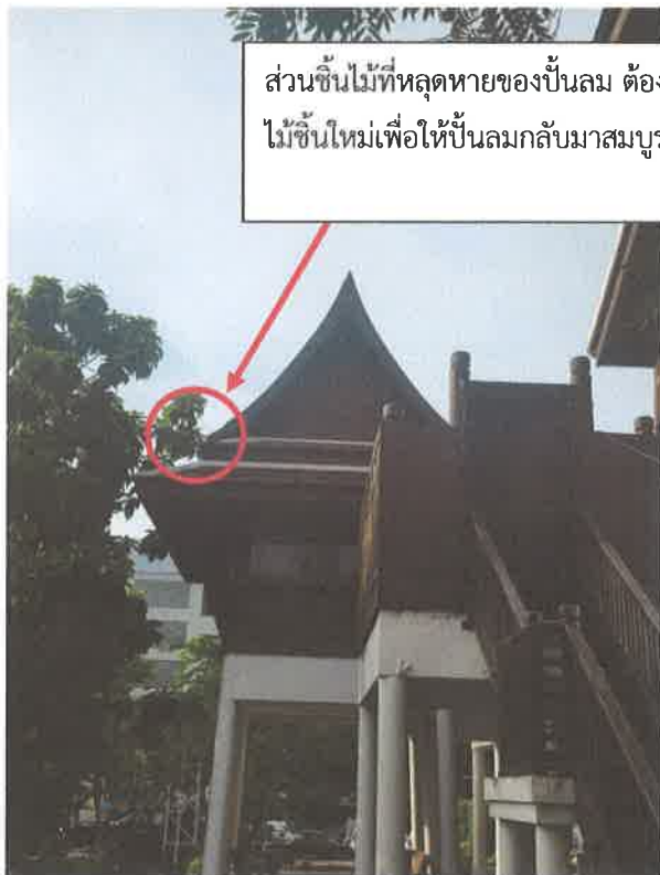
ส่วนชิ้นไม้ที่หลุดหายของปั้นลม ต้องทำการเสริมแผ่นไม้ชิ้นใหม่เพื่อให้ปั้นลมกลับมาสมบูรณ์ตามเดิม
