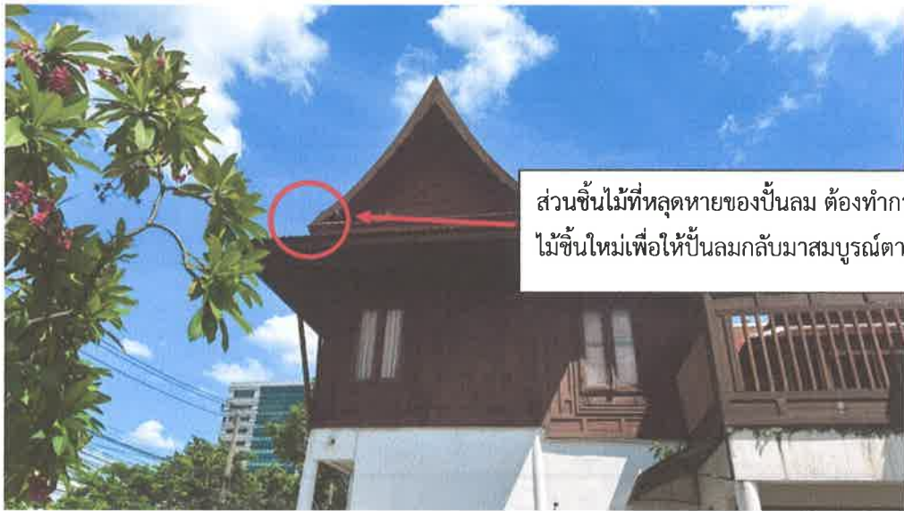
ส่วนชิ้นไม้ที่หลุดหายของปั้นลม ต้องทำการเสริมแผ่นไม้ชิ้นใหม่เพื่อให้ปั้นลมกลับมาสมบูรณ์ตามเดิม
